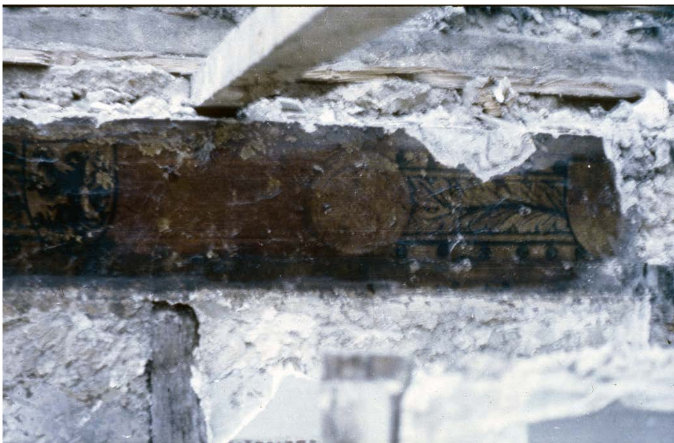
III.159. Metz, n°12-14 rue du Change, prise de vue de la peinture murale représentant une face de solive en trompe-l'oeil in situ , 1964. Photographie: A.P.-M.E.
