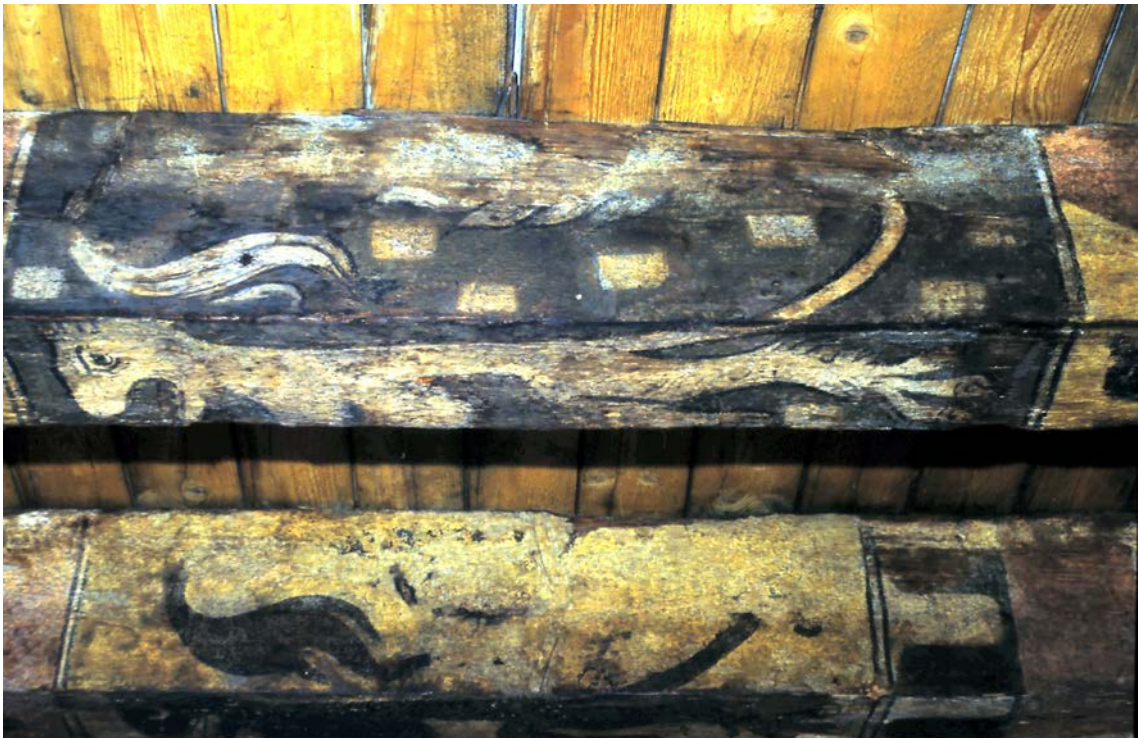
III.333. Metz, n°11 rue de la Fontaine, poutres armoriées, septembre 1995. Photographie : M.C.O.-J.-C.L.
