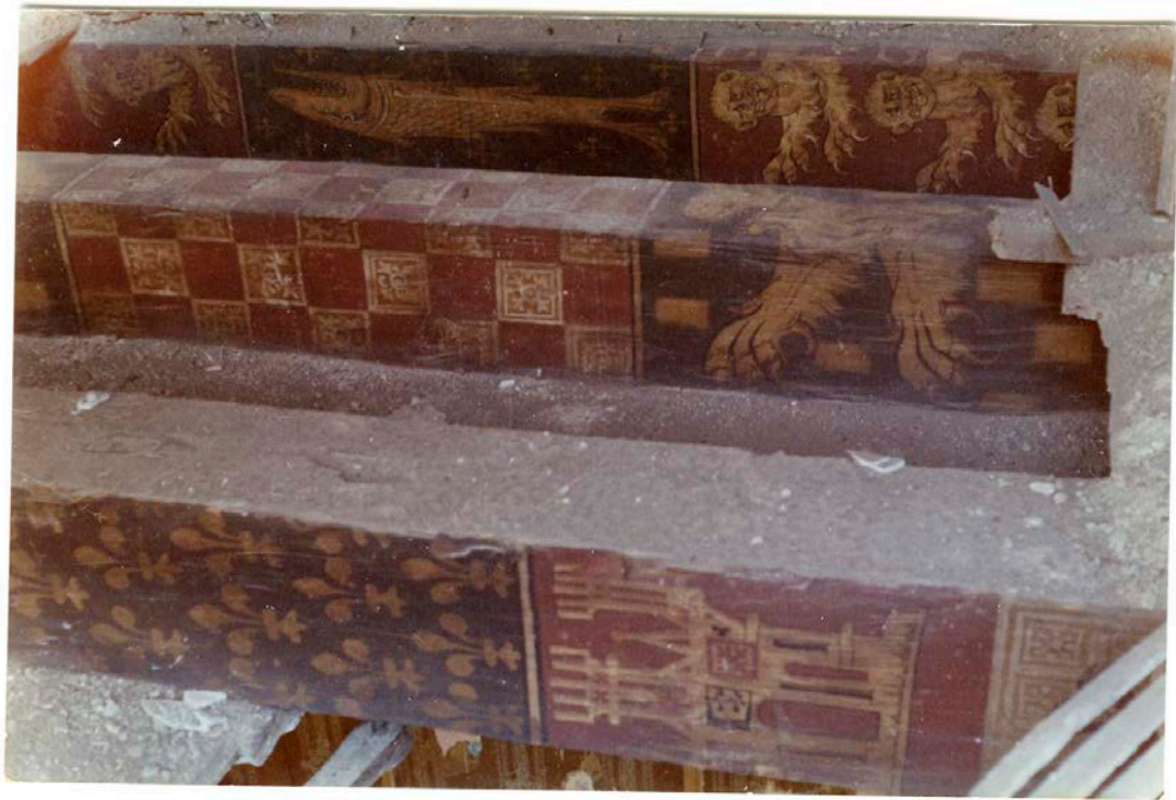
III.327. Metz, n°28 rue de la Chèvre, découverte des poutres aujourd'hui conservées au Musée de La Cour d'Or (inv.2010.0.585.), septembre 1964. Photographie : A.P.-M.E.
