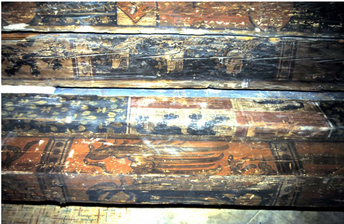
Ill.175. Metz, Musée de La Cour d'Or, solives du plafond peint du n°12-14 rue du Change (inv.2010.0.380) - poutre du n°28 rue de la Chèvre (inv.2010.0.585), 1995. Photographie: M.C.O.-J.-C.L.
