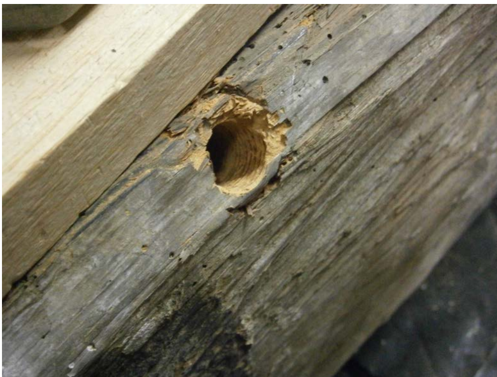
III.143. Metz, Musée de La Cour d'Or, analyse dendrochronologique du plafond peint du n°12-14 rue du Change - carottage de la solive n°VIa, 21 juillet 2011. Photographie: A.P.-N.P.
