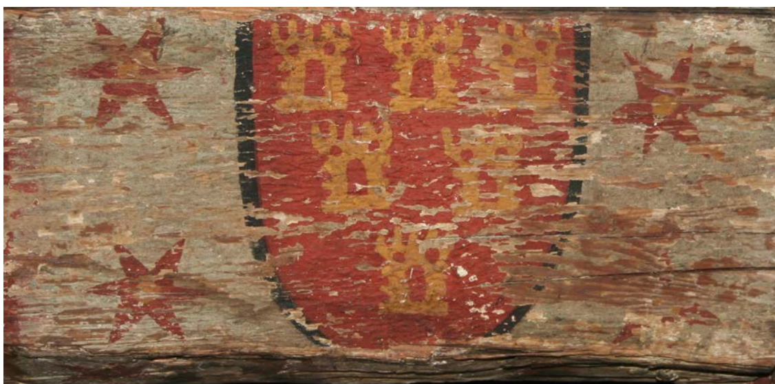
III.326. Metz, Musée de La Cour d'Or, plafond aux armoiries dit «du Républicain Lorrain» provenant du n°12 rue des Clercs à Metz (inv.84.48.1), première moitié du XV e siècle; détail des armoiries de Bertrand Le Hungre sur le chevêtre, 2011. Photographie : A.P.-N.P.
