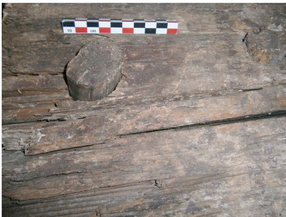
III.145. Metz, Musée de La Cour d'Or, étude tracéologique du plafond peint du n°12-14 rue du Change - détail d'un goujon en chêne à l'extrémité de la solive IIa-face B, 21 juillet 2011. Photographie: A.P.-N.P.
