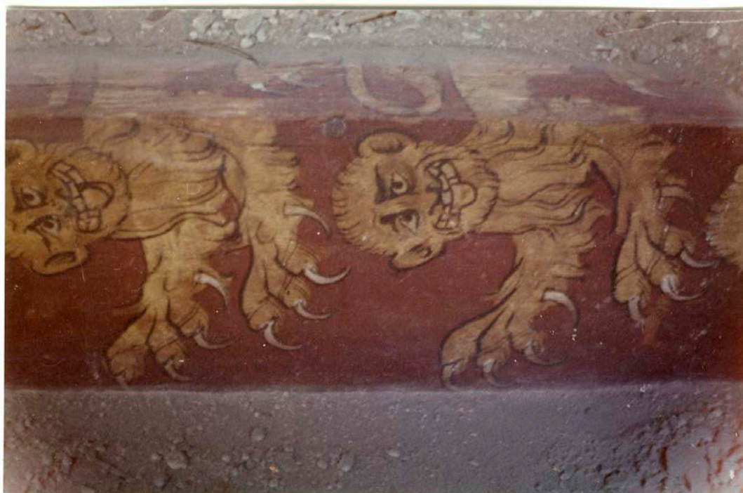
III.330. Metz, n°28 rue de la Chèvre, découverte des poutres aujourd'hui conservées au Musée de La Cour d'Or (inv.2010.0.585.); détail des léopards des armoiries du royaume d'Angleterre, septembre 1964. Photographie : A.P.-M.E.
