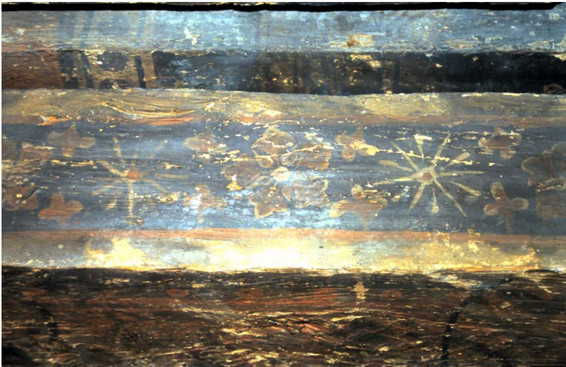
Ill.167. Metz, Musée de La Cour d'Or, solives du plafond peint du n°12-14 rue du Change (inv.2010.0.380), 1995. Photographie: M.C.O.-J.-C.L.
