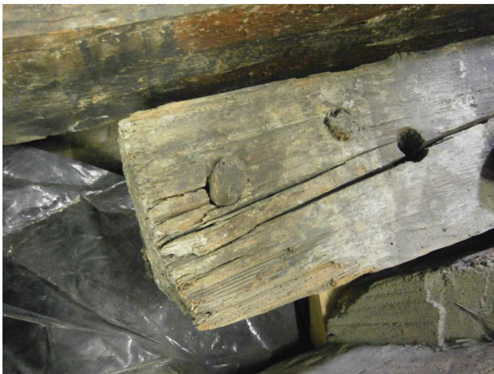
III.144. Metz, Musée de La Cour d'Or, étude tracéologique du plafond peint du n°12-14 rue du Change - goujons en chêne à l'extrémité de la solive IIa-face B, 21 juillet 2011. Photographie: A.P.-N.P.
