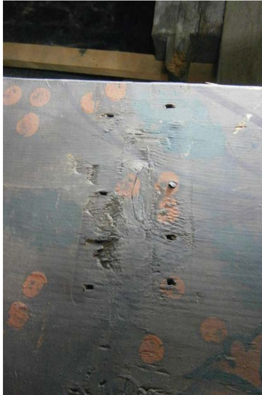
III.148. Metz, Musée de La Cour d'Or, étude tracéologique du plafond peint du n°12-14 rue du Change - marques de clous récents qui ont probablement servi à fixer le faux plafond de plâtre, planche n°8b, 18 juillet 2011. Photographie: A.P.-N.P.
