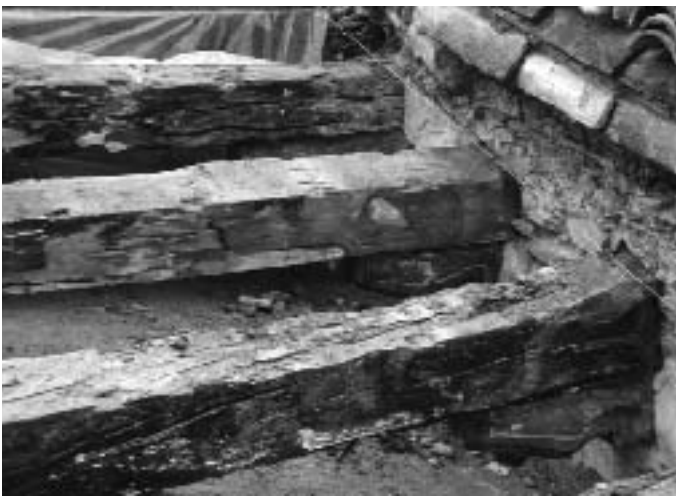
fig. 1 - Deux engoulants sur charpente, en place cl. commune d'Aragon, 1993
