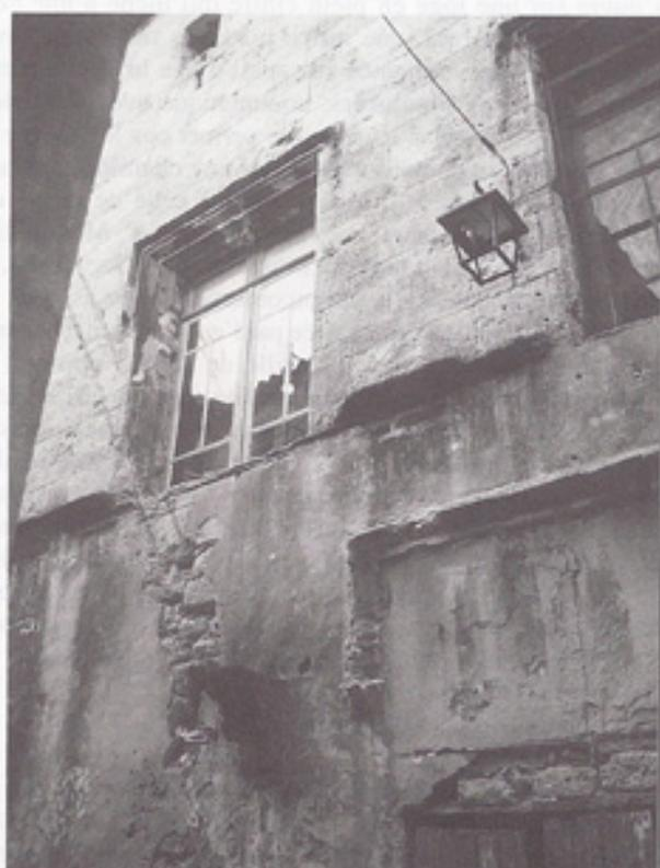
Fig. 2 : Façade ouest. Fenêtres à croisée (disparue) dans un mur en appareil de Montpellier. 2<sup>e</sup> période.
