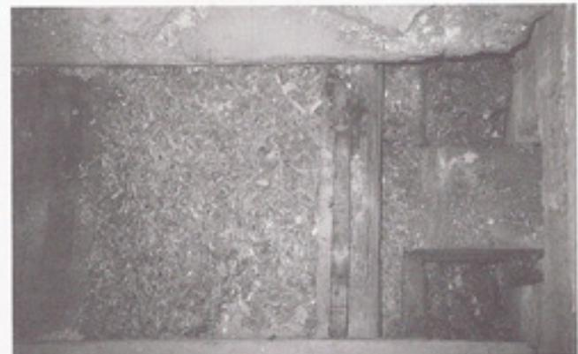
Fig. 10 : Vue d'un sondage par dessus un appui de poutre. On note les cales des planches sur les solives, la continuité des solives sur les poutres et surtout le bourrage des vides par de la paille.
