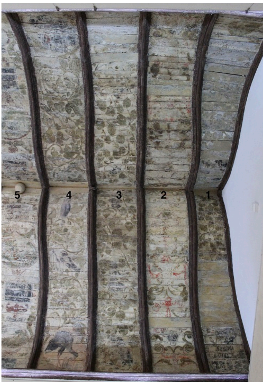
Figure 5 : Travées 1 à 5 du plafond de la galerie d'Amboise au Palais de la Berbie
