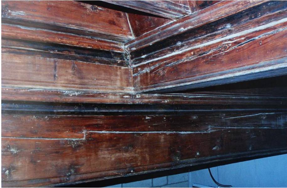
Figure 9 Poutre armée, XVe siècle, Musée du Petit Palais, Avignon (Guibal, Bouticourt, 2010)
