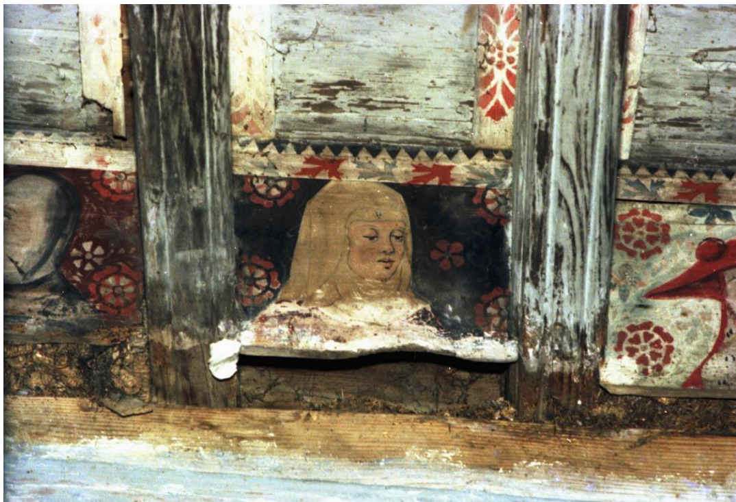
Figure 42 Charpente , 1492-1493, salle haute, Château de Pomas
