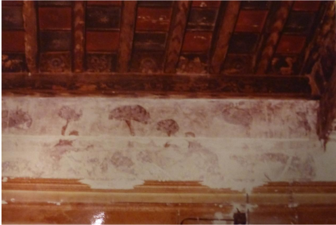
Figure 17 Salle 1er étage, vers 1336, Livrée dite de Viviers, Avignon
