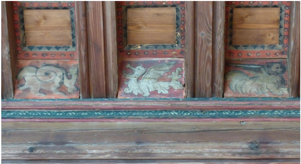
Figure 51 Charpente, fin XVe siècle, Salon du roi, 1e étage, Tarascon
