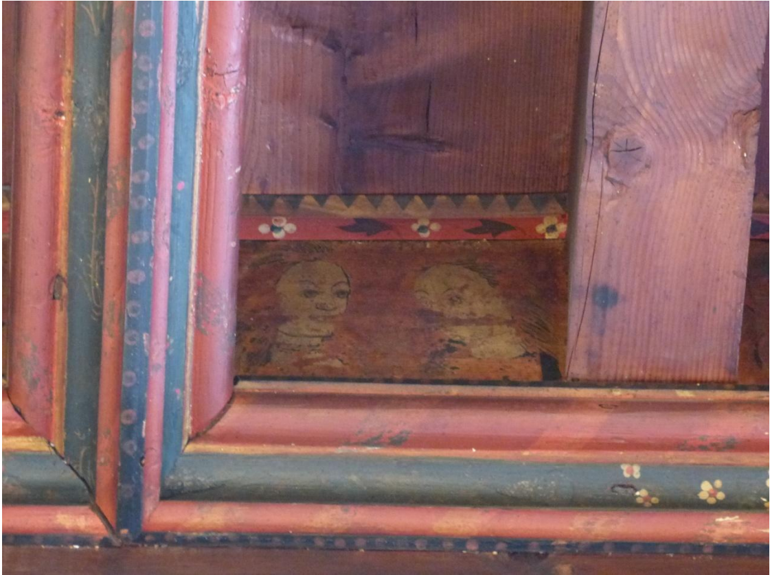
Figure 71 Couple en buste , closoir, charpente salle du 1er étage, Hôtel Barocelli, Palais du Roure, Avignon
