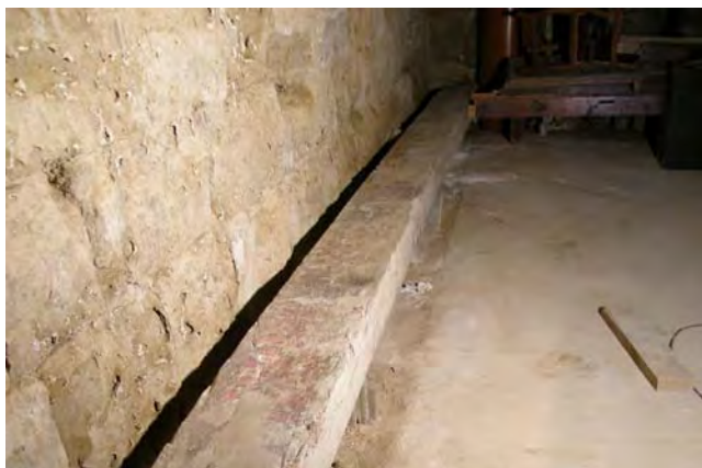
Figuras 31 y 32. La viga del siglo XV desmontada en el XVII y depositada en el tinell, detalle de su policromía con las manos y el rosario. Fotografías: Artyco, Archivo General IPCE.
