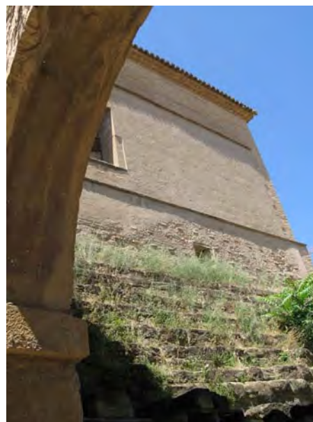
Figura 20. Contrafuerte escalonado en la base del muro oriental del salón del alfarje. Fotografía: Ana Carrassón.
