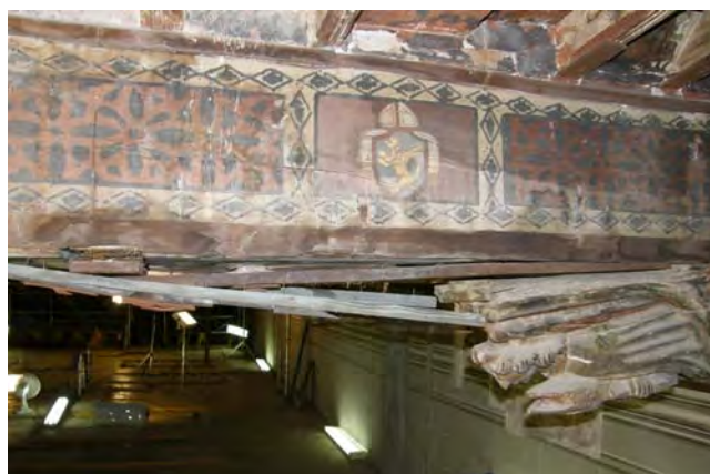
Figura 27. Viga IV con el tablero de refuerzo y pletinas de hierro. Fotografía: Artyco, Archivo General IPCE.
