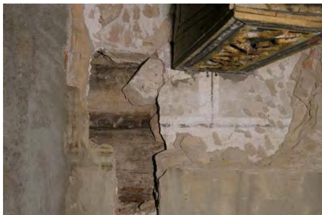
Figura 43. Catas de inspección realizadas en la unión entre la pintura mural y el alfarje. Fotografía: Artyco, Archivo General IPCE.
