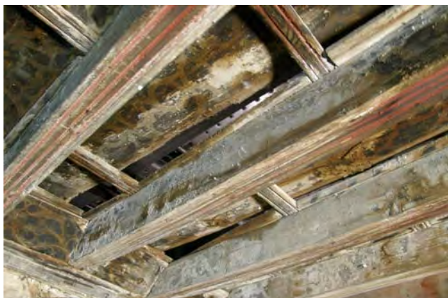
Figura 41. Efectos de las filtraciones de agua en la policromía. Fotografía: Artyco, Archivo General IPCE.
