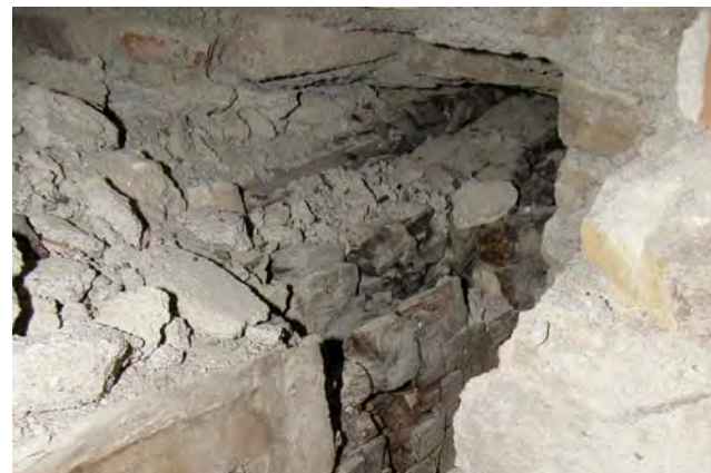
Figura 34. Pudrición de la cabeza de viga XI. Fotografía: Artyco, Archivo General IPCE.
