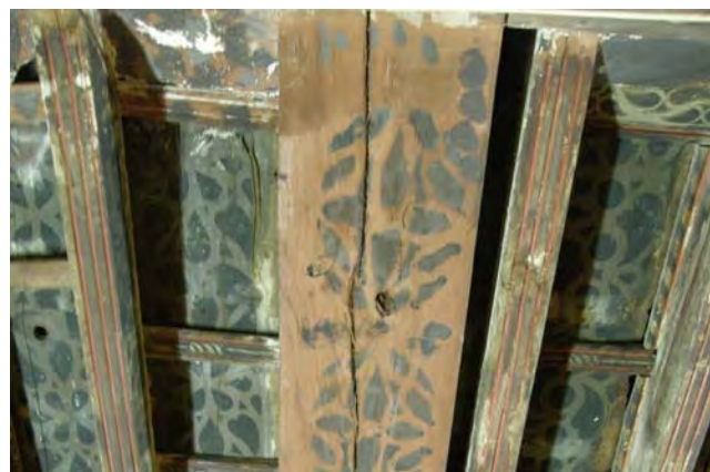
Figura 26. Viga de refuerzo aplicada en la calle IV. Fotografía: Artyco, Archivo General IPCE.
