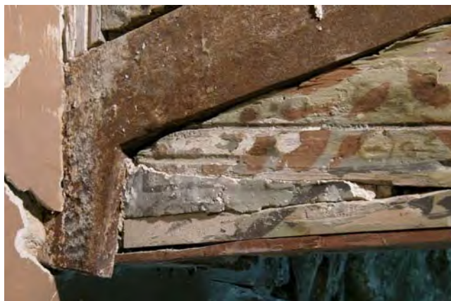
Figura 23. Algunos refuerzos de hierro en las jácenas. Fotografía: Artyco, Archivo General IPCE.
