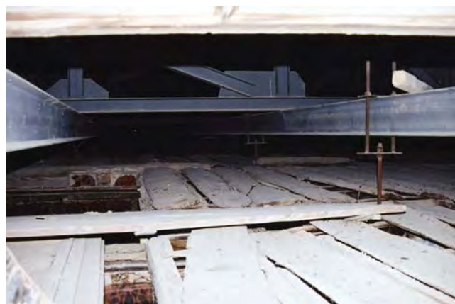
Figura 4. Sistema de colgado de la techumbre. Fotografía: Ana Carrassón.
