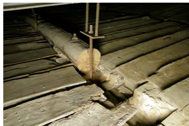
Figura 28. Elementos de cuelgue del alfarje y madero de refuerzo. Fotografía: Artyco, Archivo General IPCE.
