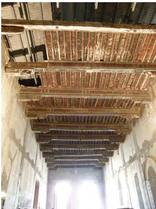
Figura 1. Vista general, sur norte, de la sala con la techumbre Tanto Monta. Fotografía: Artyco, Archivo General IPCE.
