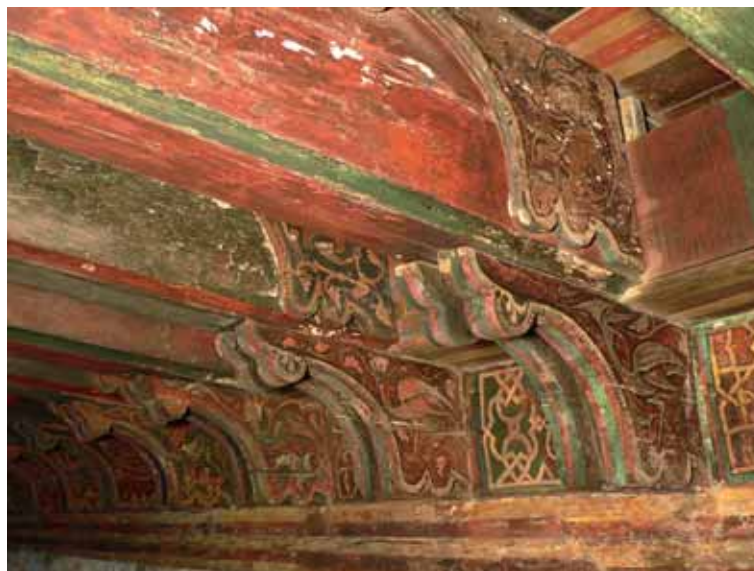
Figure 6.7 : Vue générale des deux niveaux de support du plancher, rive sud. (Cl. A. Marin, 2004)
