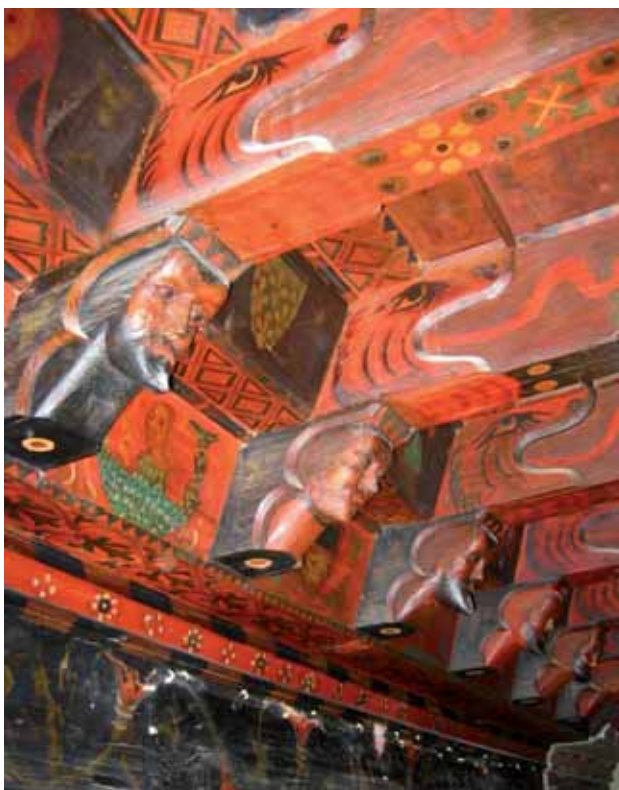
Figure 8.10 : Béziers (3e quart du XV e s.), maison impasse de la Notairie, extrémités des solives du plancher.
