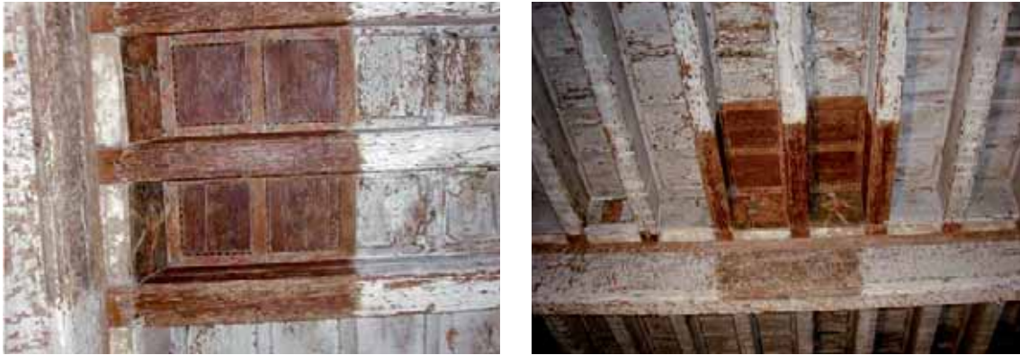
Figures 11.10 et 11.11 : Maison au 51 de la rue de Verdun à Carcassonne, XVe siècle. Expertise réalisée sur les plafonds de l'étage mettant en évidence l'existence d'un décor peint. Vues de la partie dégagée.
