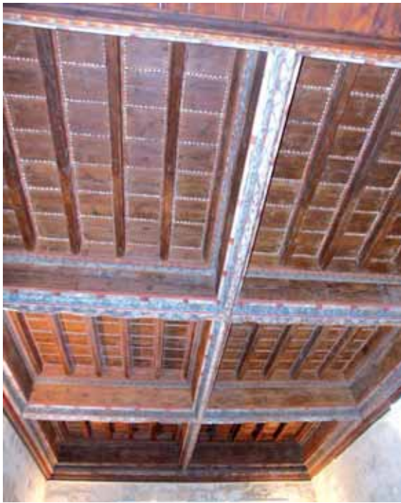
Figure 7.6 : Plafond de la loge de Jacques Cœur, vue d'ensemble.
