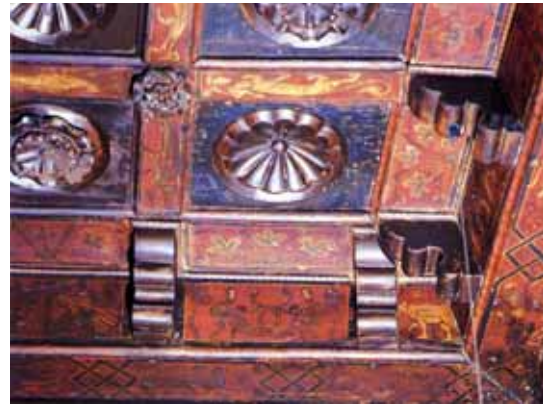
Figure 7.3 : Détail du plafond de l’hostal des Bucelli.
