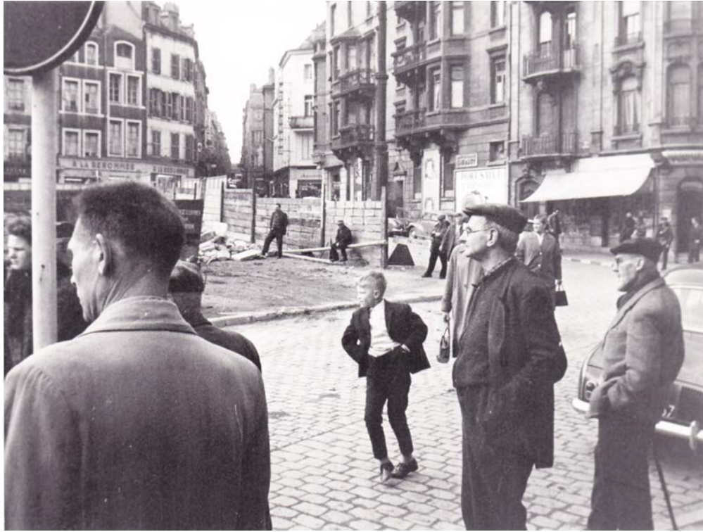
III.24. Metz, un quartier ancien disparaît - îlot du Change, mars 1964. Photographie: A.M.M. 2fi219.
