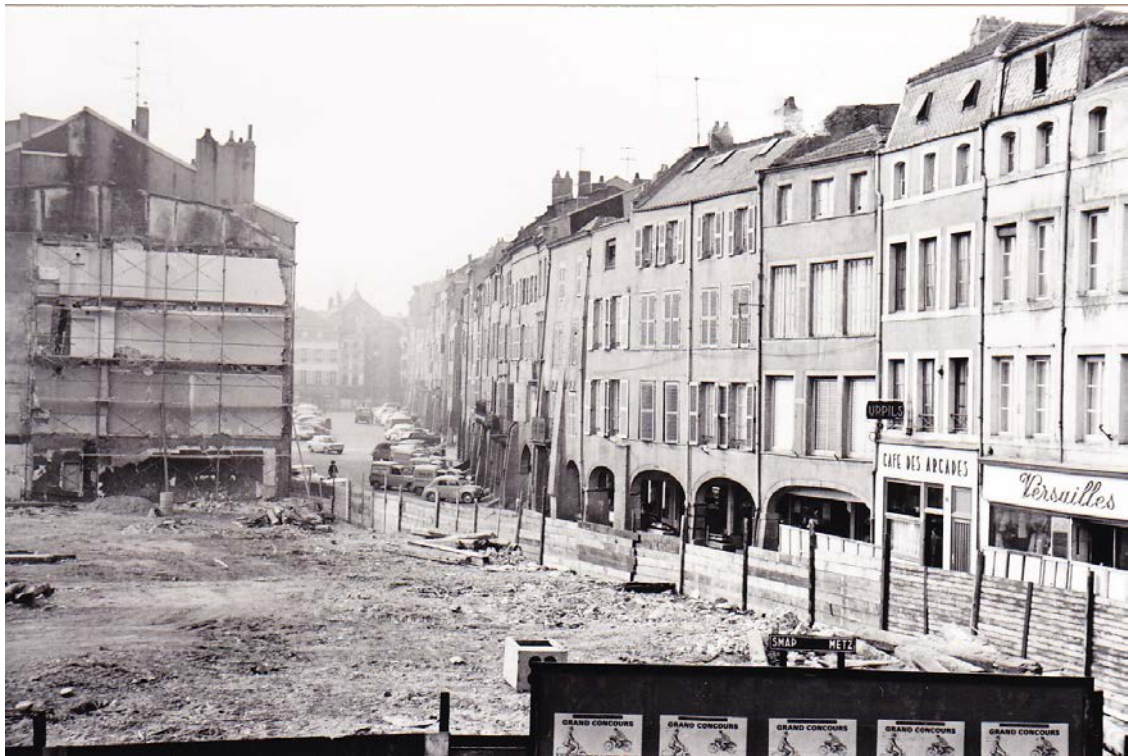
III.28. Metz, démolition de l'îlot du Change - vue sur la place Saint-Louis, 1964. Photographie: S.R.I.
