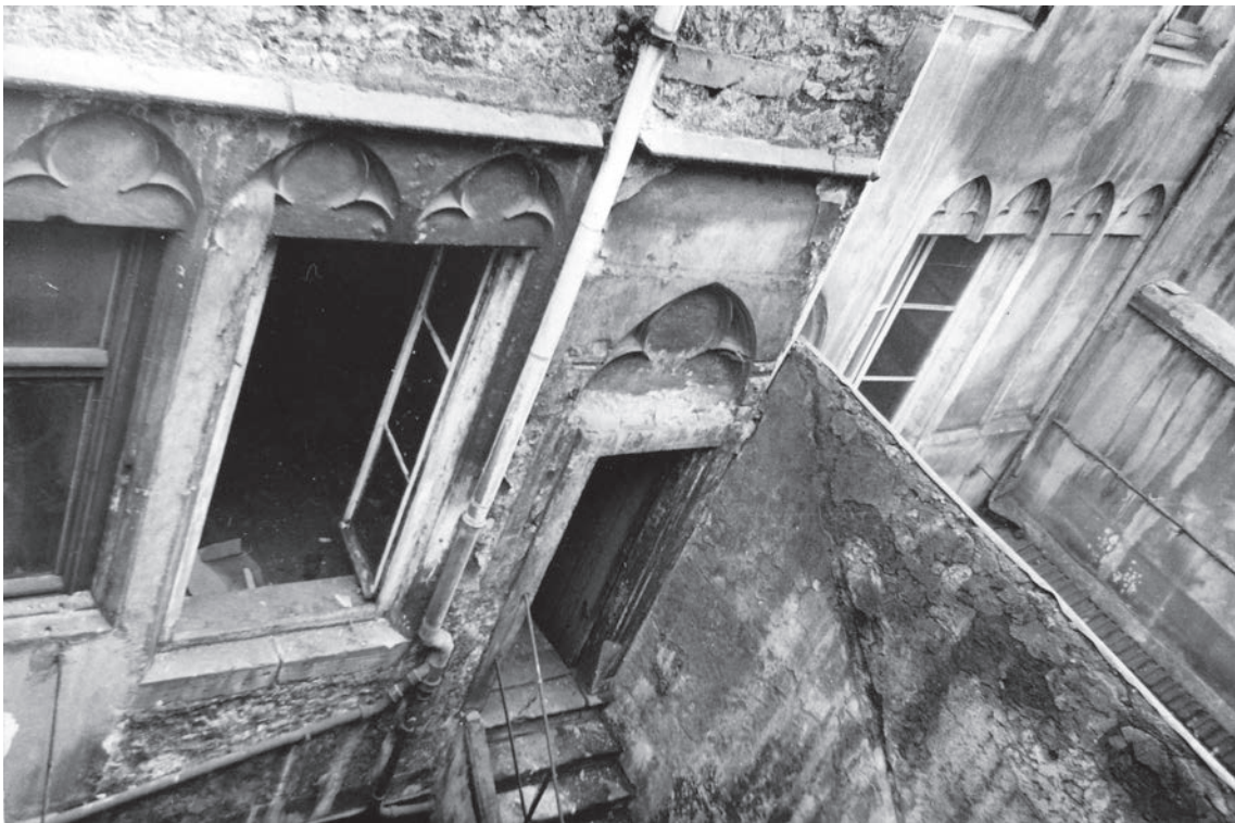
III.63. Metz, vue de la façade est depuis le second étage du corps de bâtiment A ; façade sur cour du n°16 rue du Change derrière le muret, 1963. Photographie: A.P.-M.E.
