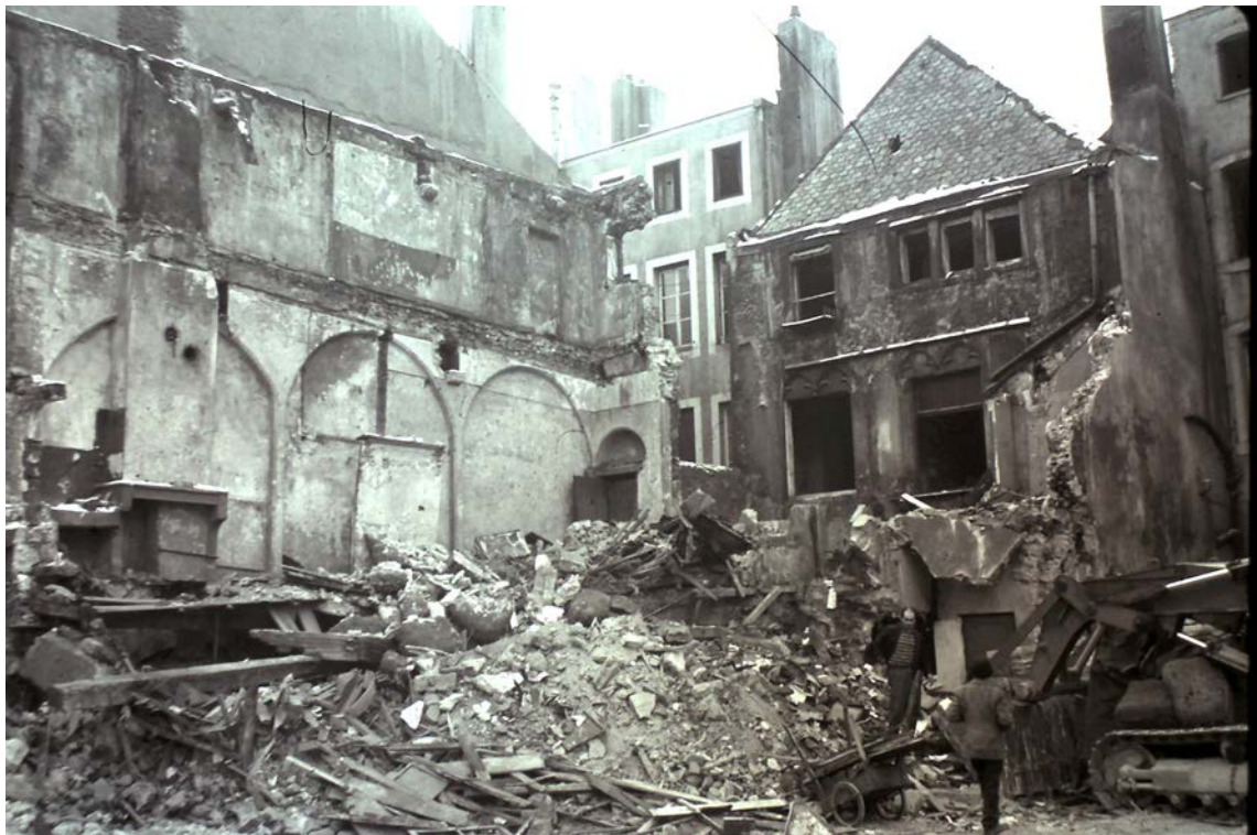
III.54. Metz, destruction de la maison n°12-14 rue du Change- corps de bâtiment B: arcades médiévales du premier étage apparentes, 1963. Photographie: A.P.-M.E.
