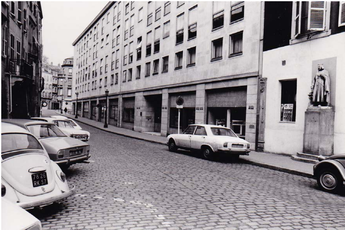
III.30. Metz, rue du Change - les nouvelles constructions, 1972. Photographie: A.M.M. 2fi308 .
