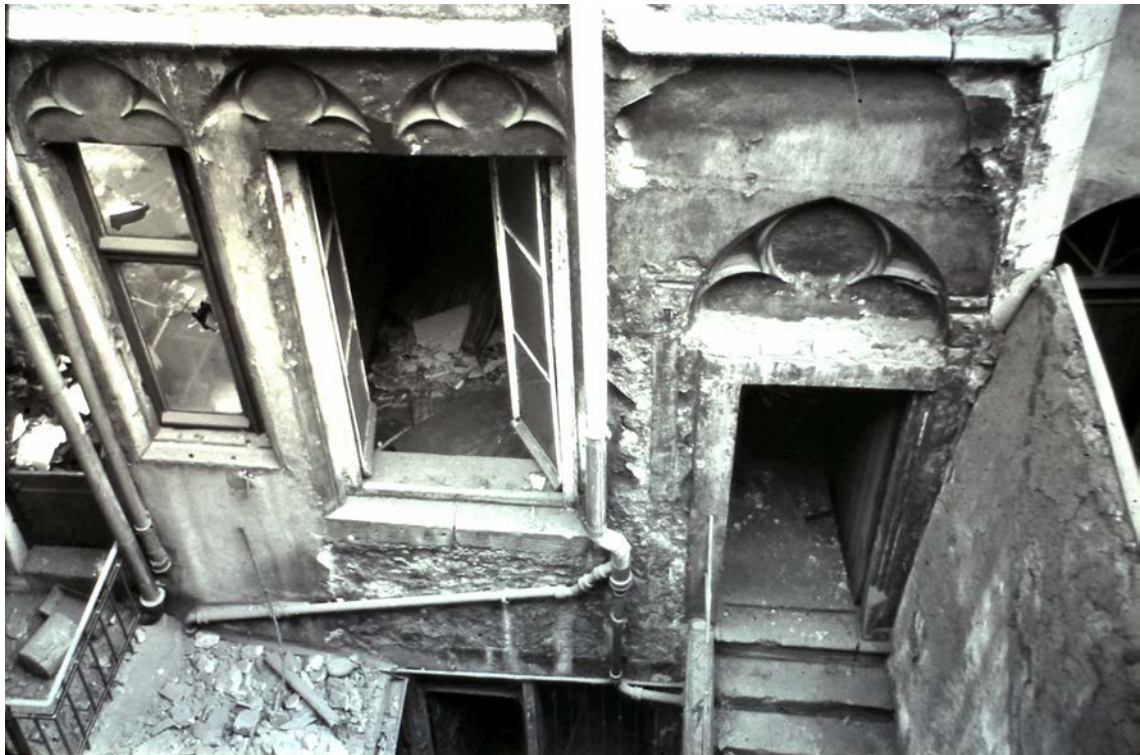
III.62. Metz, vue de la façade est depuis le second étage du corps de bâtiment A, 1963. Photographie: A.P.-M.E.
