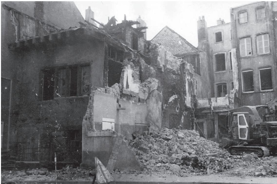
III.76. Metz, vue de la façade à pans de bois rue Haute-Seille- corps de bâtiment B du n°12-14, 1963. Photographie: A.P.-M.E.
