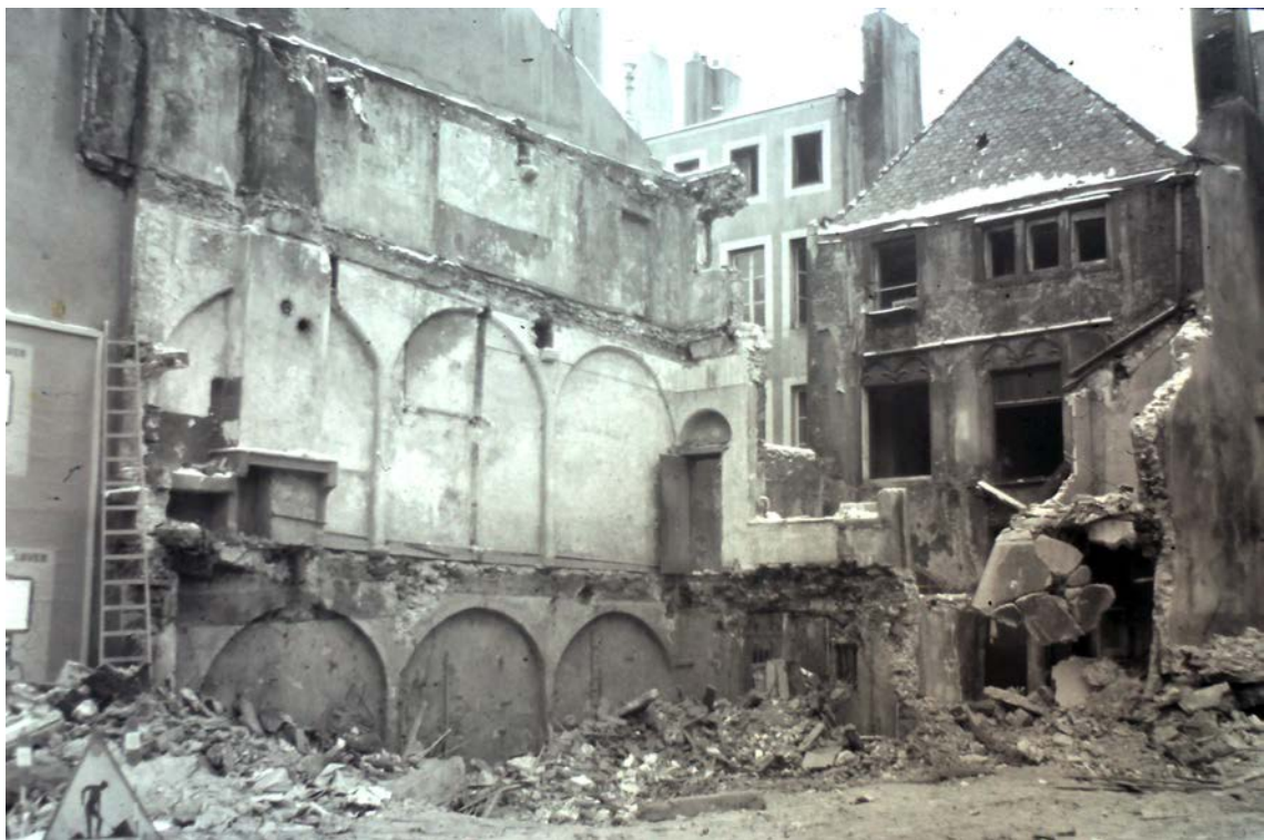
III.55. Metz, destruction de la maison n°12-14 rue du Change- corps de bâtiment B: arcades médiévales du rez-de-chaussée et du premier étage apparentes, 1963. Photographie: A.P.-M.E.
