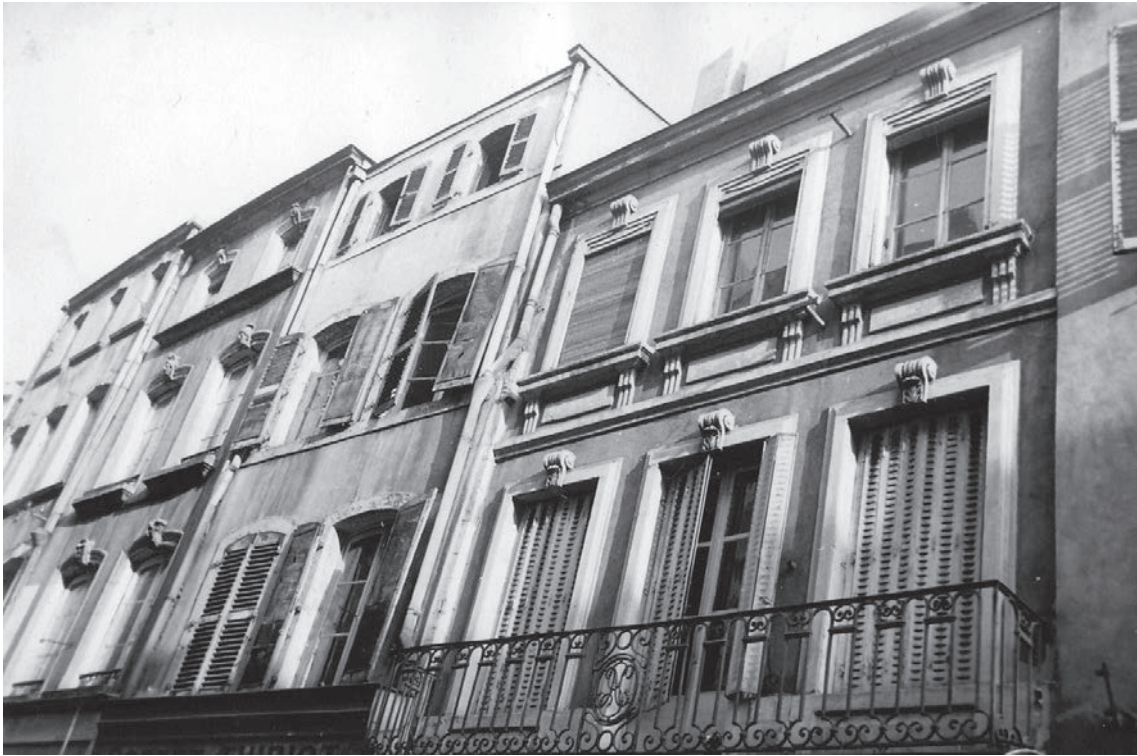
III.45. Metz, façade du n°12 rue du Change, début des années 1960. Photographie: A.P.-M.E.
