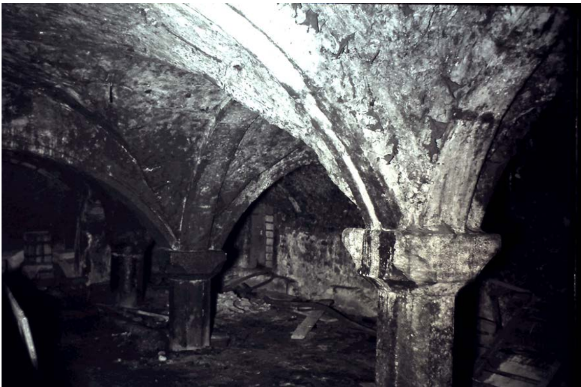
III.49. Metz, cave voûtée du n°16 rue du Change, 1963. Photographie: A.P.-M.E.
