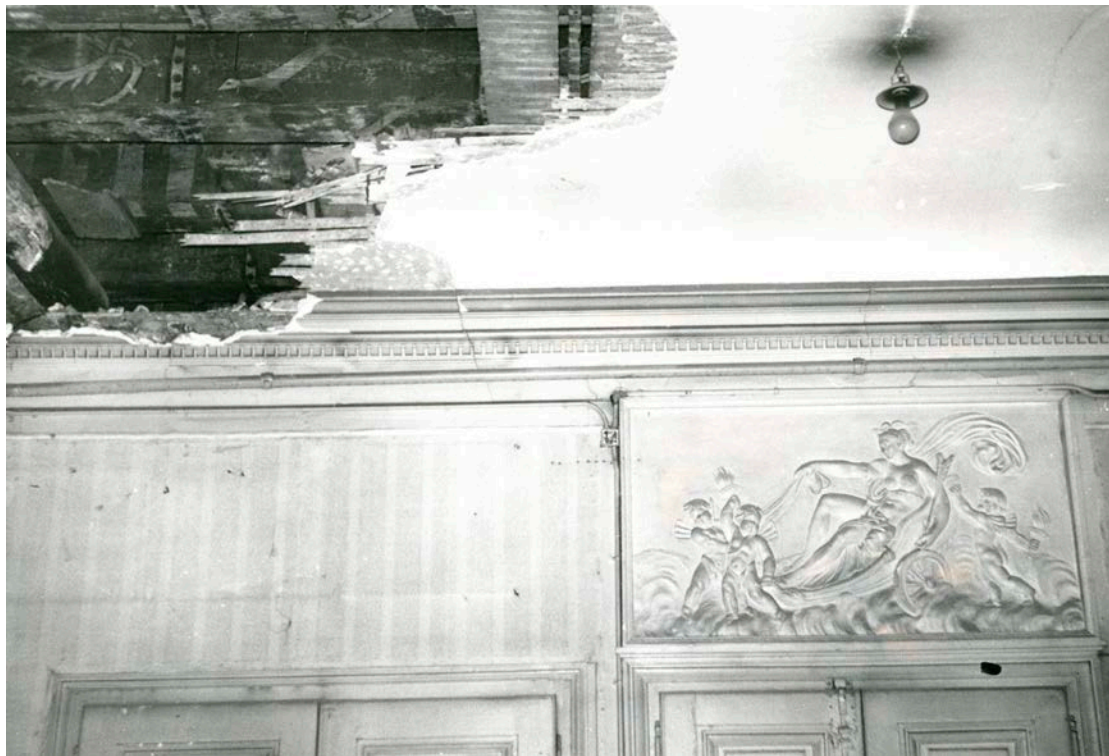
III.33. Metz, découverte du plafond aux armoiries dit « du Républicain Lorrain» sous un faux plafond de plâtre, 6 mars 1968. Photographie: M.C.O.
