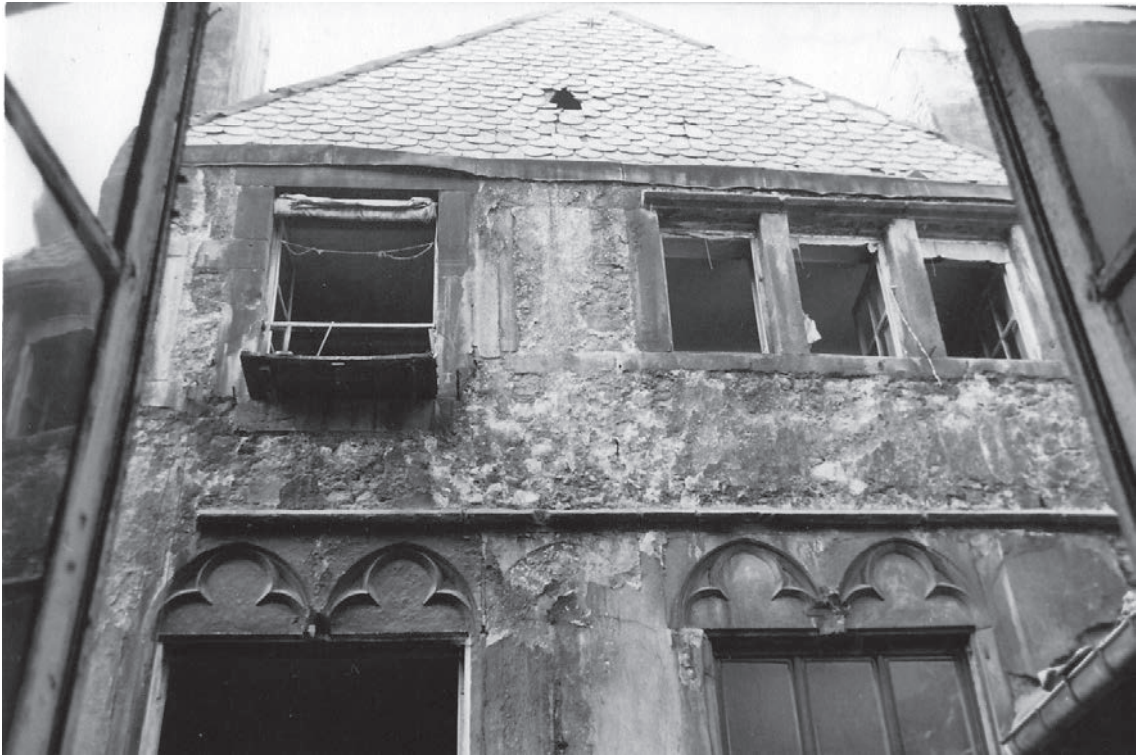
III.50. Metz, façade sur cour côté ouest - fenêtres gothiques à tympanes trilobés, corniche et attique, 1963. Photographie: A.P.-M.E.
