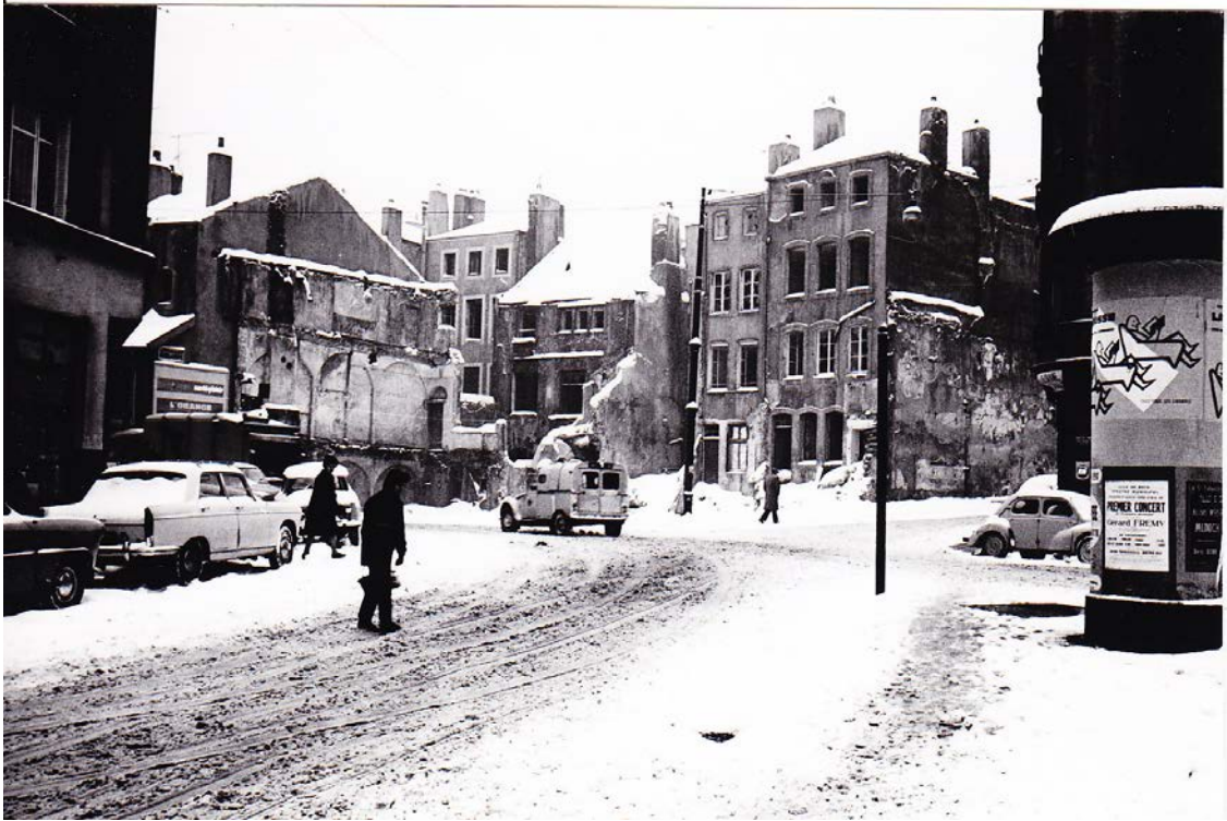
III.16. Metz, vue de l'îlot du Change depuis la place des Paraiges - bâtiment arrière de la maison n°12-14 rue du Change: arcades médiévales apparentes, 1963. Photographie: S.R.I.
