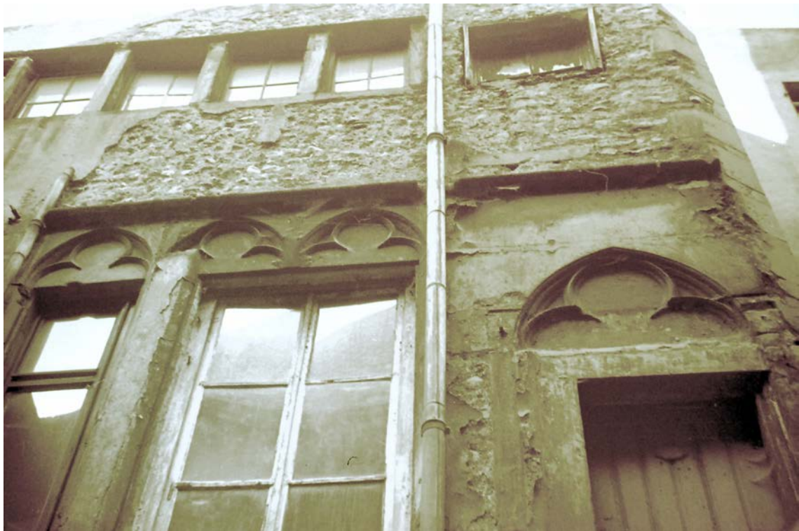
III.68. Metz, vue de la façade est depuis la cour : porte et fenêtres gothiques à tympan trilobé de l'étage noble, corniche et petites fenêtres carrées de l'attique, 1963. Photographie: A.P.-M.E.
